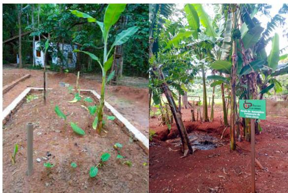
podem ser de 2 metros e 1,2 metros, respectivamente. O comprimento é variável, sendo que para uma residência com 4 pessoas, pode ser utilizado 5 metros. É recomendado que o dimensionamento e a instalação ocorram com orientação de profissional capacitado por formação teórica e/ou prática.
