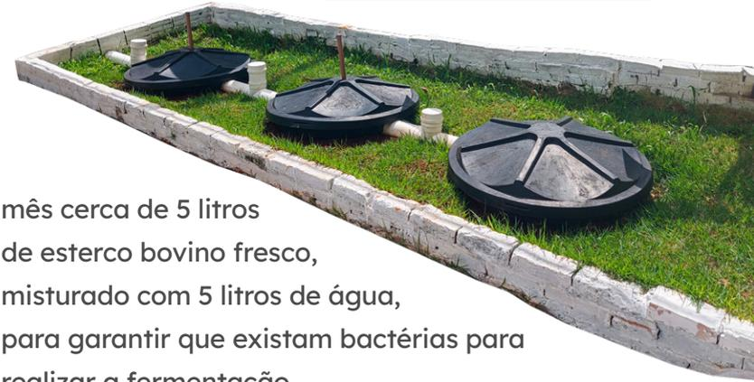
mês cerca de 5 litros de esterco bovino fresco, misturado com 5 litros de água, para garantir que existam bactérias para realizar a fermentação.
